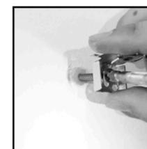
Posicione o suporte sobre a bucha aplicada e coloque o parafuso do seu kit parafusando-o com uma chave de fenda/philips ou uma parafusadeira.
